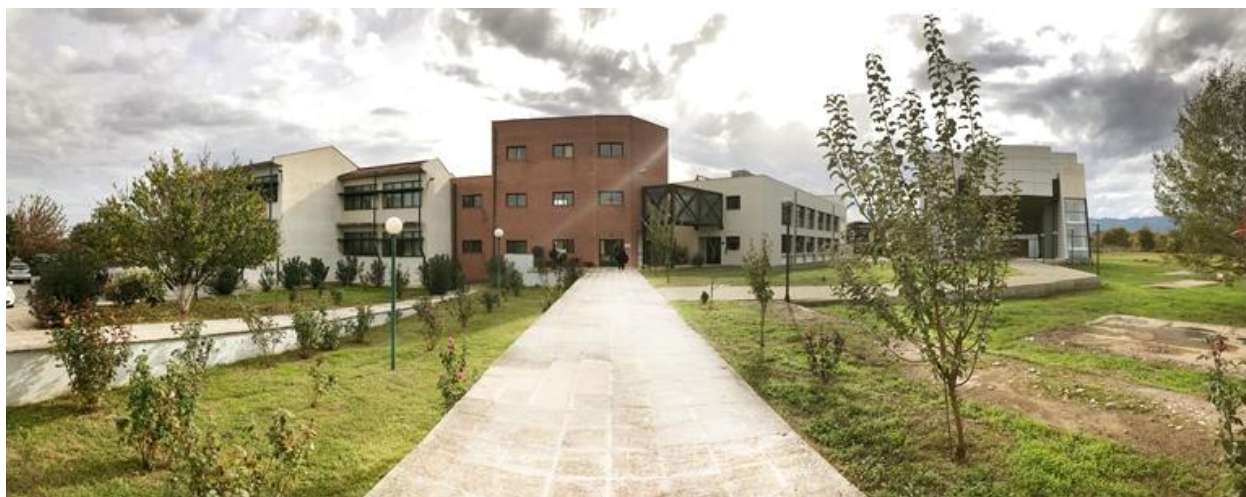
Μέρος των εγκαταστάσεων του ΤΕΦΑΑ.
