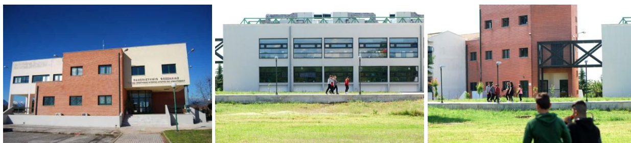
Μέρος των εγκαταστάσεων του ΤΕΦΑΑ.
